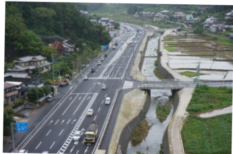
国道 34 号大村諫早拡幅
