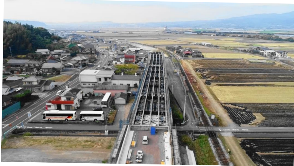
● 国道 57 号森山拡幅（釜ノ鼻 2 号橋周辺）
