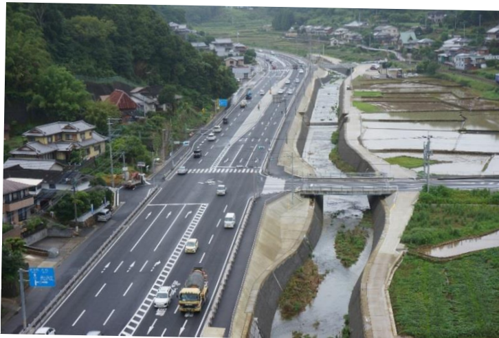
● 国道 34 号大村諫早拡幅
