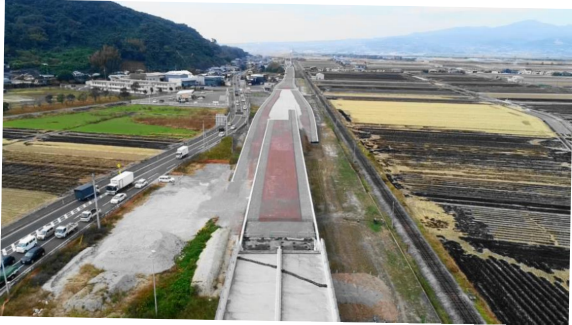
● 地域高規格道路「島原道路」(森山東インターチェンジ付近)
