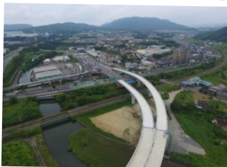
地域高規格道路「島原道路」 (諫早インターチェンジ付近)
