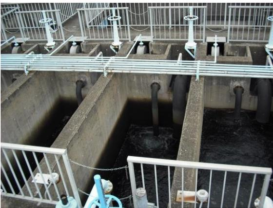
\* 平山浄水場の急速ろ過池
