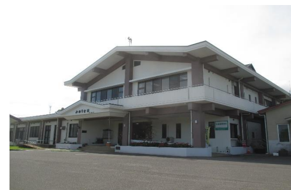
完成（外壁：みのり会館）
