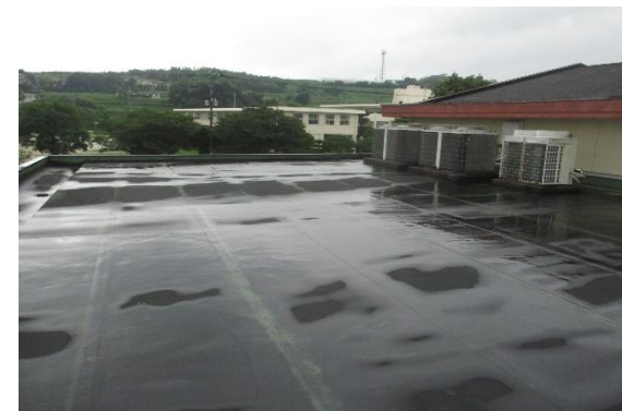
着工前（屋根／防水：みのり会館）
