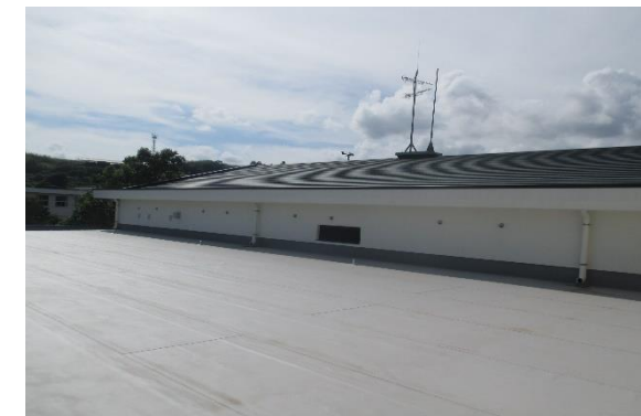
完成（屋根／防水：みのり会館）
