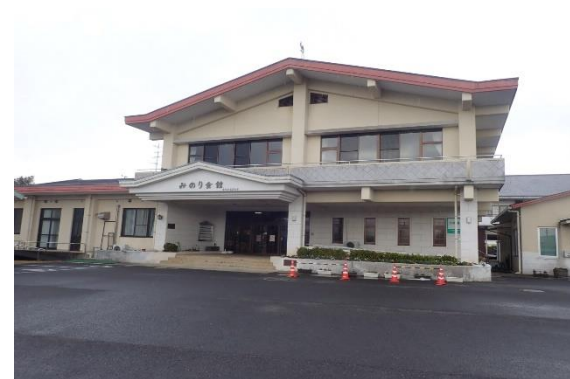
着工前（外壁：みのり会館）
