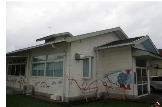
着工前（外壁／屋根：園芸伝習所）
