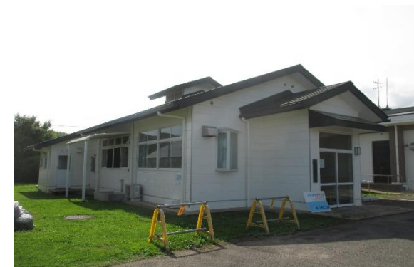
完成（外壁／屋根：園芸伝習所）
