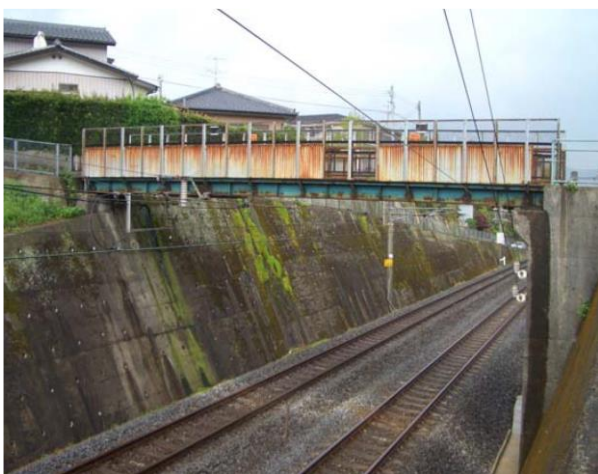
橋りょう補修事業
