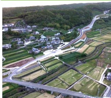
工事用道路（市道赤水線） 供用開始（R6.12）
