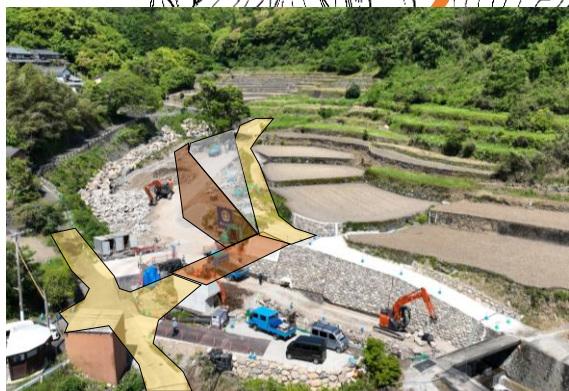
河川公園施工状況
