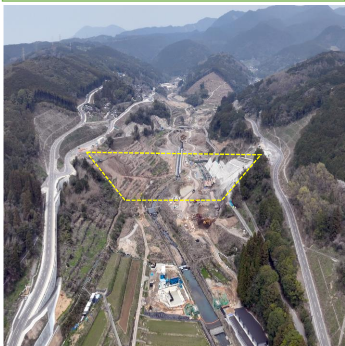
ダム本体工事施工中（R8.3）
