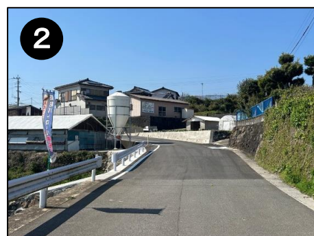
市道小船津西尾線(道路拡幅整備)
