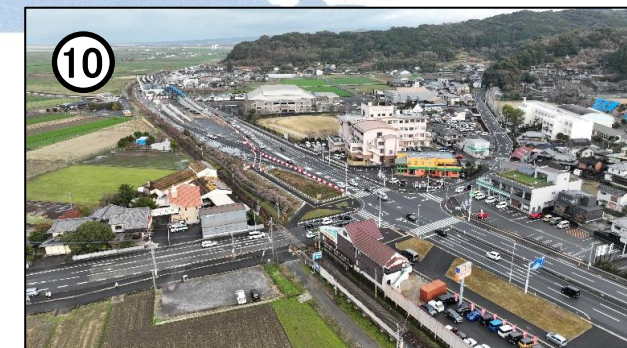
国道57号【森山拡幅 尾崎IC付近】 (施工中)
