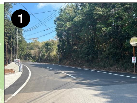
市道田原線(道路拡幅整備)
