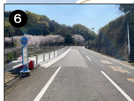
市道大門戸石線(歩道整備)
