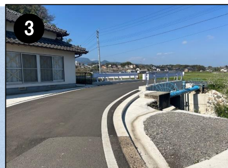
市道正久寺白浜線(橋梁更新)
