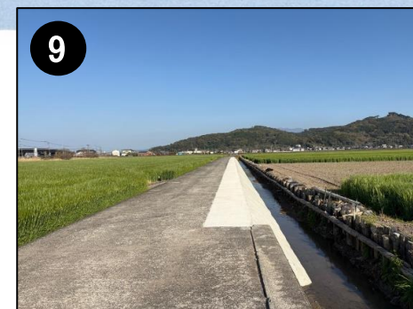
市道外籠1号線(道路整備)
