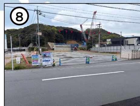
一般県道久山港線【久山工区】 (施工中)
