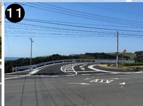
市道早見線(道路整備)
