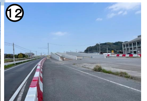
国道57号【森山拡幅】 (施工中)
