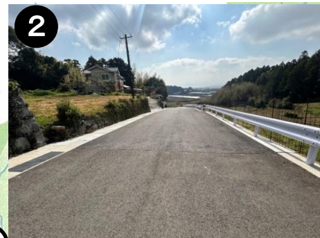
市道星ノ久保線(道路整備)
