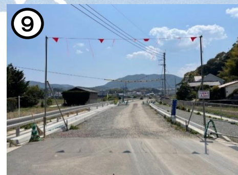
一般県道久山港線【久山工区】 (施工中)
