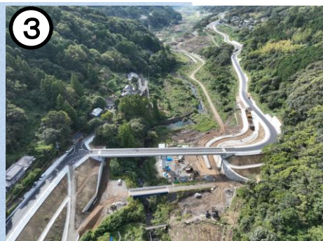
市道古場落線【本明川ダム事業関連】 (道路整備)
