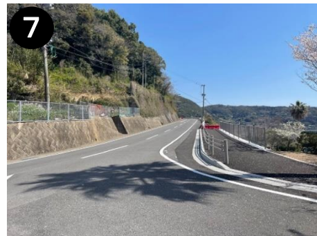
市道大門戸石線(道路整備)
