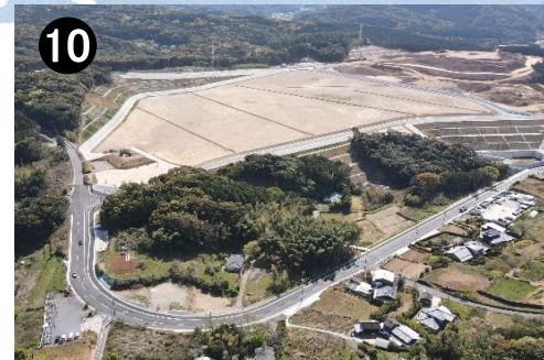
市道栗面小ヶ倉線(道路整備)
