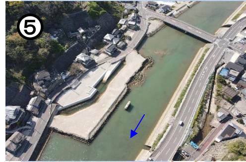
市道井樋線【江ノ浦川総合流域防災事業関連】
