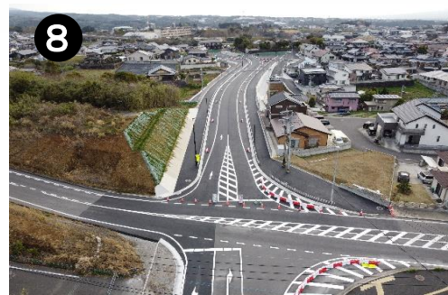
都市計画道路堀の内西栄田線 (道路整備)
