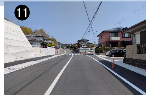
市道蔭平白岩線(道路整備)
