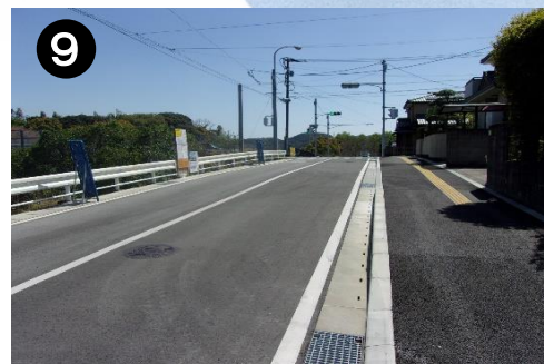
市道山川町1号線(歩道整備)
