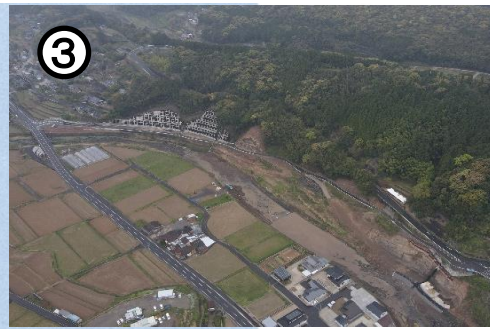
市道赤水線【本明川ダム事業関連】 (道路整備)
