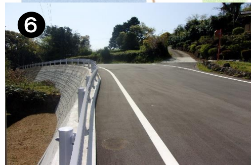
市道出口平床線(道路整備)
