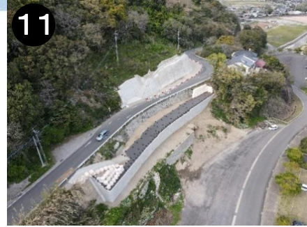
⑪ 市道大門戸石線(道路整備)
