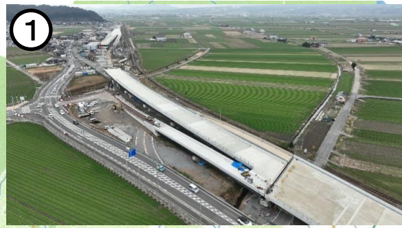
① 国道57号【森山拡幅】 (自動車専用道路)
