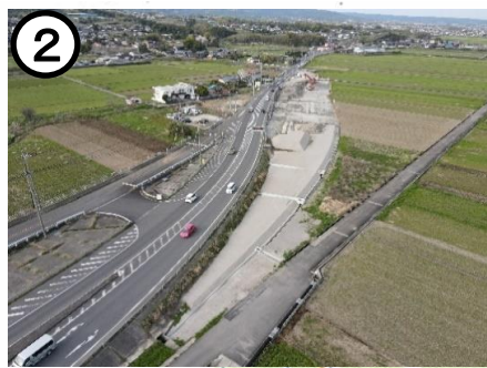
② 国道207号【東長田拡幅】 (道路整備)
