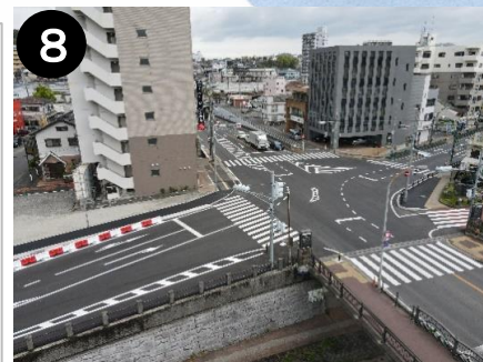
⑧ 市道上宇戸橋公園線【四面橋交差点改良】 (道路整備)
