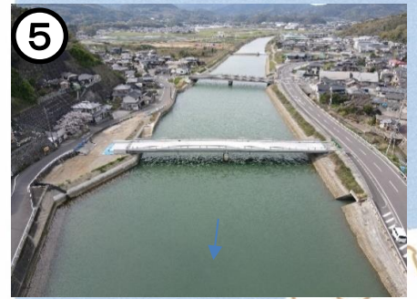
⑤ 市道井樋線【江ノ浦川総合流域防災事業関連】 (道路整備)
