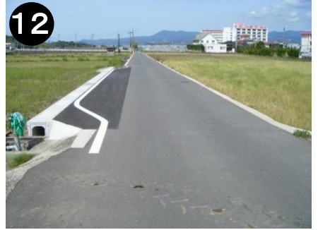
⑫ 市道舟津田原線(道路整備)
