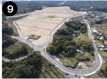
⑨ 市道栗面小ヶ倉線【南諫早産業団地関連】 (道路整備)
