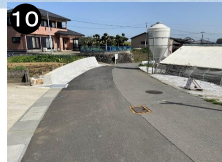
市道小船津西尾線（道路整備）
