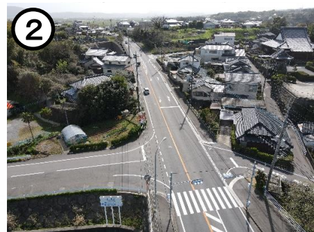
国道207号【大戸工区】 （道路整備）
