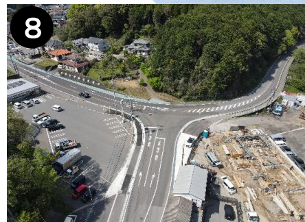
市道栗面小ヶ倉線【南諫早産業団地関連】 （道路整備）
