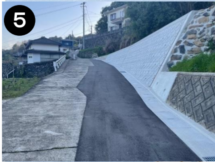
市道二ヶ倉線（道路整備）
