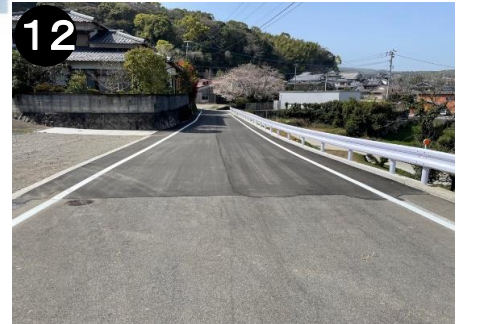
市道出口平床線（道路整備）
