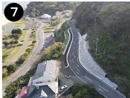
市道大門戸石線（道路整備）
