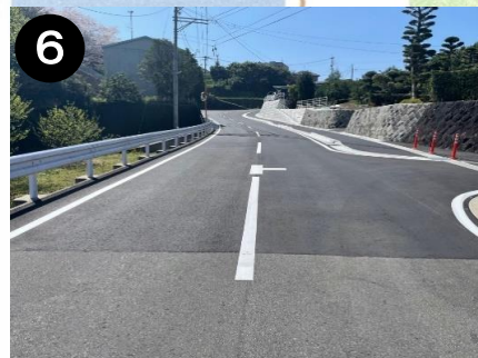
市道蔭平白岩線（道路整備）
