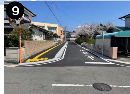
市道山川町1号線外（歩道整備） （道路整備）
