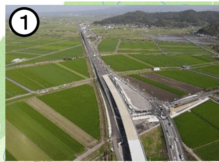
国道57号【森山拡幅】 （森山西インターチェンジ）
