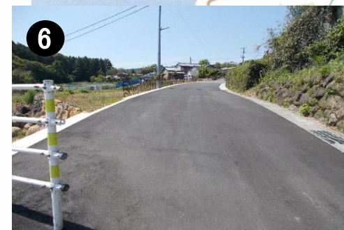
市道星ノ久保線(道路整備)
