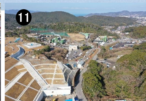
市道栗面小ヶ倉線(道路整備)
