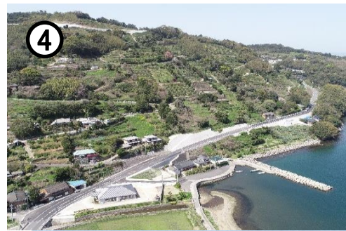
国道207号【佐瀬拡幅】 (道路整備)
