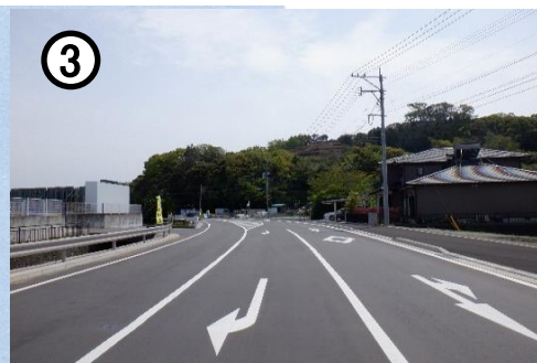
一般県道久山港線【久山工区】 (道路整備)
