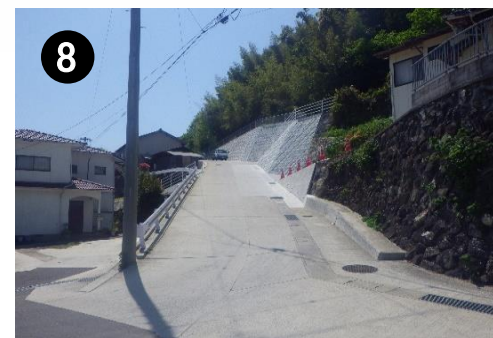
市道ニヶ倉線(道路整備)
