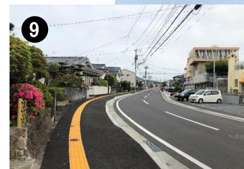
市道山川町1号線(歩道整備)
