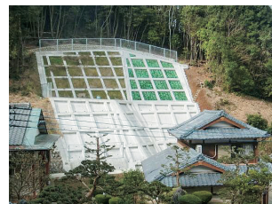
急傾斜地崩壊対策
