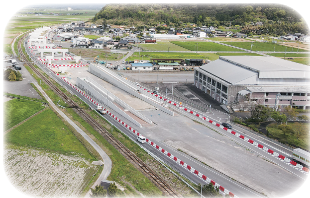
整備中の島原道路(尾崎交差点付近)
