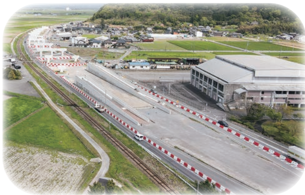
整備中の島原道路(尾崎交差点付近)
