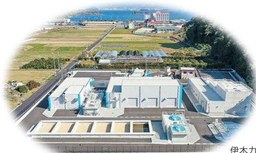
伊木力浄水場
