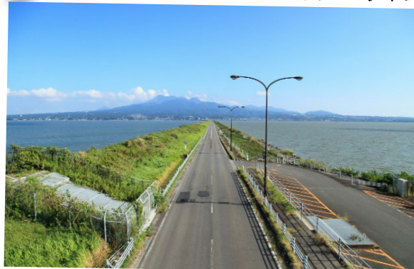
● 諫早湾干拓堤防道路（雲仙多良シーライン）
