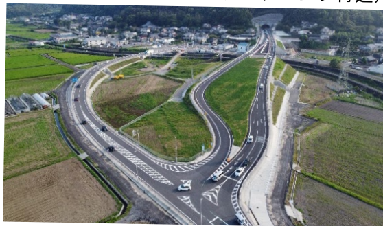
● 高規格道路「島原道路」 (長野インターチェンジ付近)
