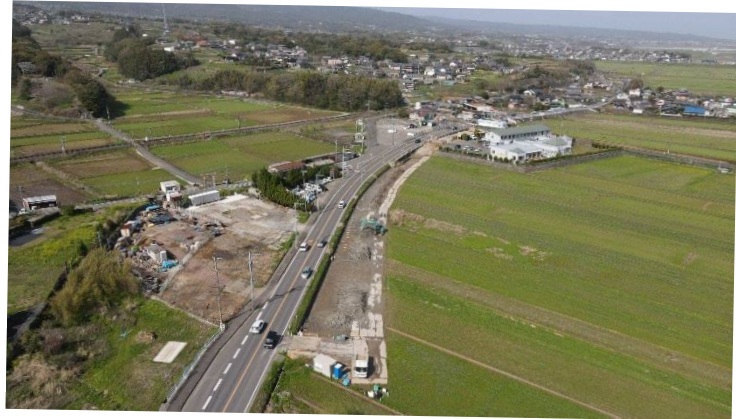
● 国道 207 号長田バイパス（高天町～高来町方向）
