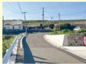
⑦市道早見線 (道路拡幅整備)
