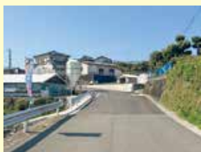
②市道小船津西尾線 (道路拡幅整備)
