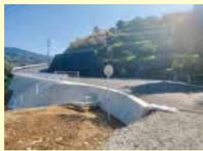
⑤市道百石中通線 (道路拡幅整備)
