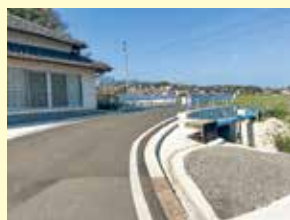
③市道正久寺白浜線 (橋梁更新)
