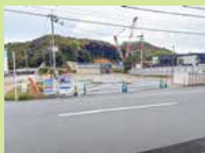
⑨一般県道久山港線 【久山工区】(施工中)
