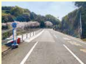
⑥市道大門戸石線 (歩道整備)
