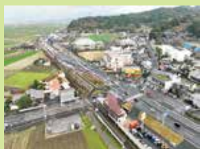
⑩国道57号 【森山拡幅 尾崎 IC 付近】 (施工中)
