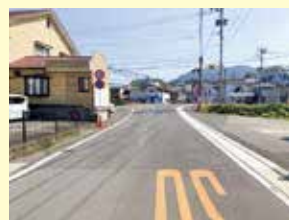
④市道久山化屋線 (踏切改良)
