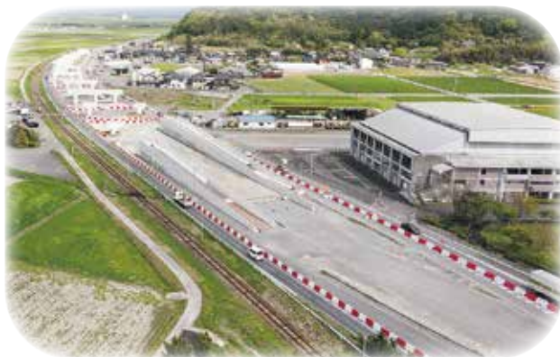
整備中の島原道路(尾崎交差点付近)
