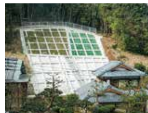
急傾斜地崩壊対策
