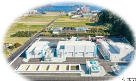
伊木力浄水場
