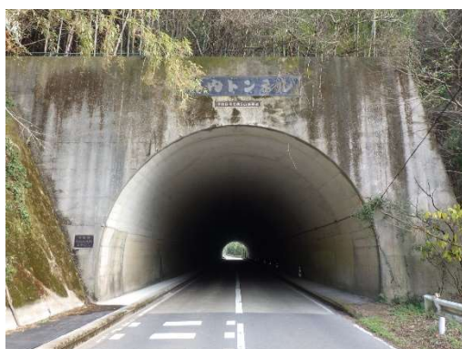
諫早市側坑口
