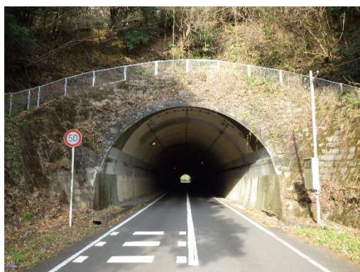
諫早市側坑口
