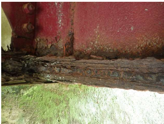
鋼桁の腐食
