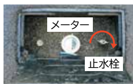
【写真2】 止水栓を回して水を止める。
