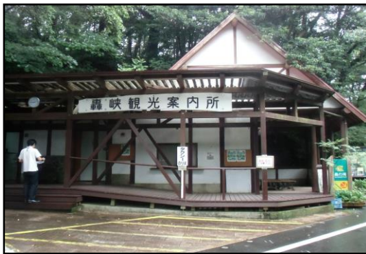
全景（駐車場側から撮影）
