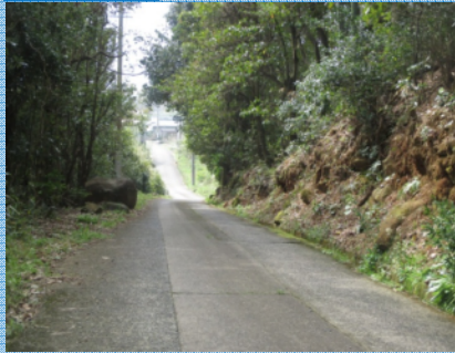
★ がけ崩れ・落石注意
