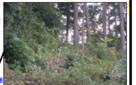
倒木・法面崩壊の恐れ(大雨時)
