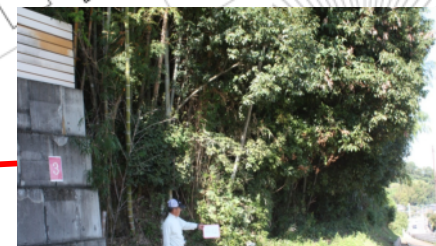
大雨時、崩壊注意
