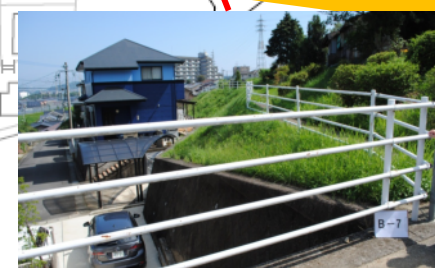
大雨時、雨水流れ・崩壊注意
