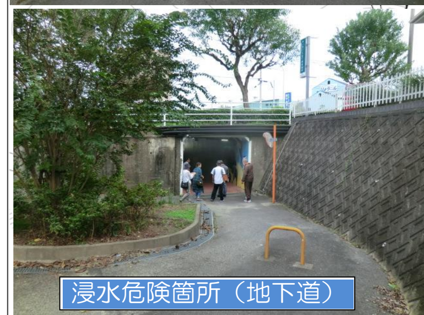
浸水危険箇所 (地下道)
