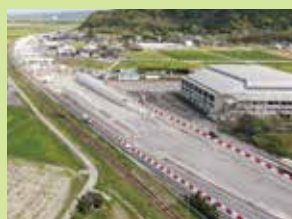
⑩国道57号 【森山拡幅】(施工中)
