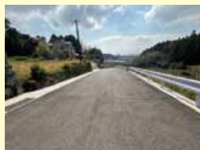
②市道星ノ久保線 (道路整備)
