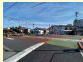
⑧市道久山化屋線 (踏切改良)
