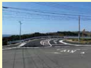
⑥市道早見線 (道路整備)
