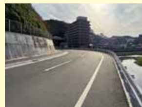
④市道上宇戸橋公園線 (道路整備)
