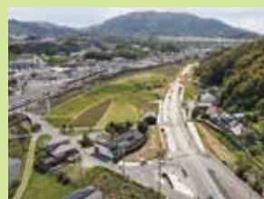
⑪一般県道久山港線 【久山工区】(施工中)
