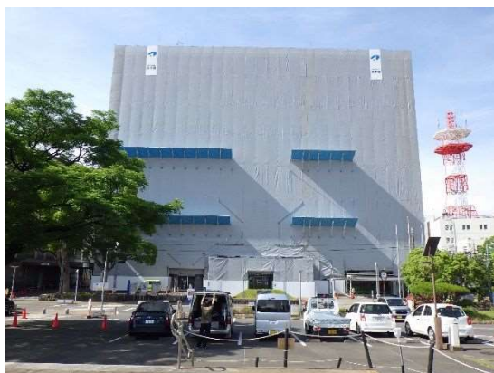
【外壁】外壁補修工事
