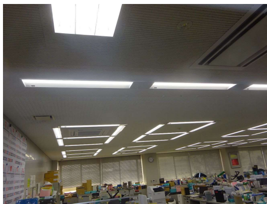
【LED 照明】令和6年度改修
