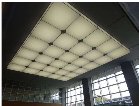
【LED照明】令和6年度改修
