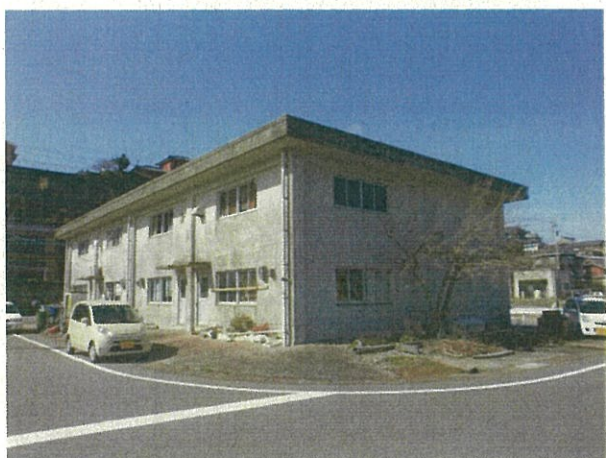
有3 47.有喜地区漁船修理施設
