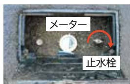
【写真2】 止水栓を回して水を止める。
