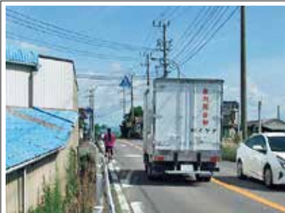
④七浦西部地区の拡幅改良、歩道の早期整備
