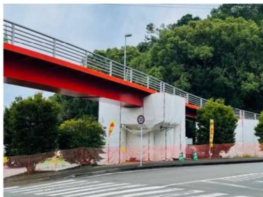
橋りょう補修事業
