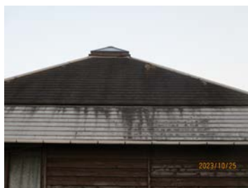
屋根材の老朽化・汚れ(甚兵衛住宅)
