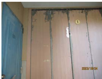
自転車置き場鉄部錆 (西郷町ふたば住宅)
