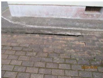
外壁塗装劣化・カビ (西園住宅)
