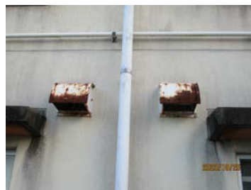
換気扇フード錆、雨樋塗装劣化(慶師野住宅)
