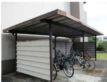
自転車置き場鉄部錆 (西郷町ふたば住宅)
