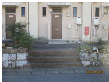
階段手摺未設置(小船越町東住宅)
