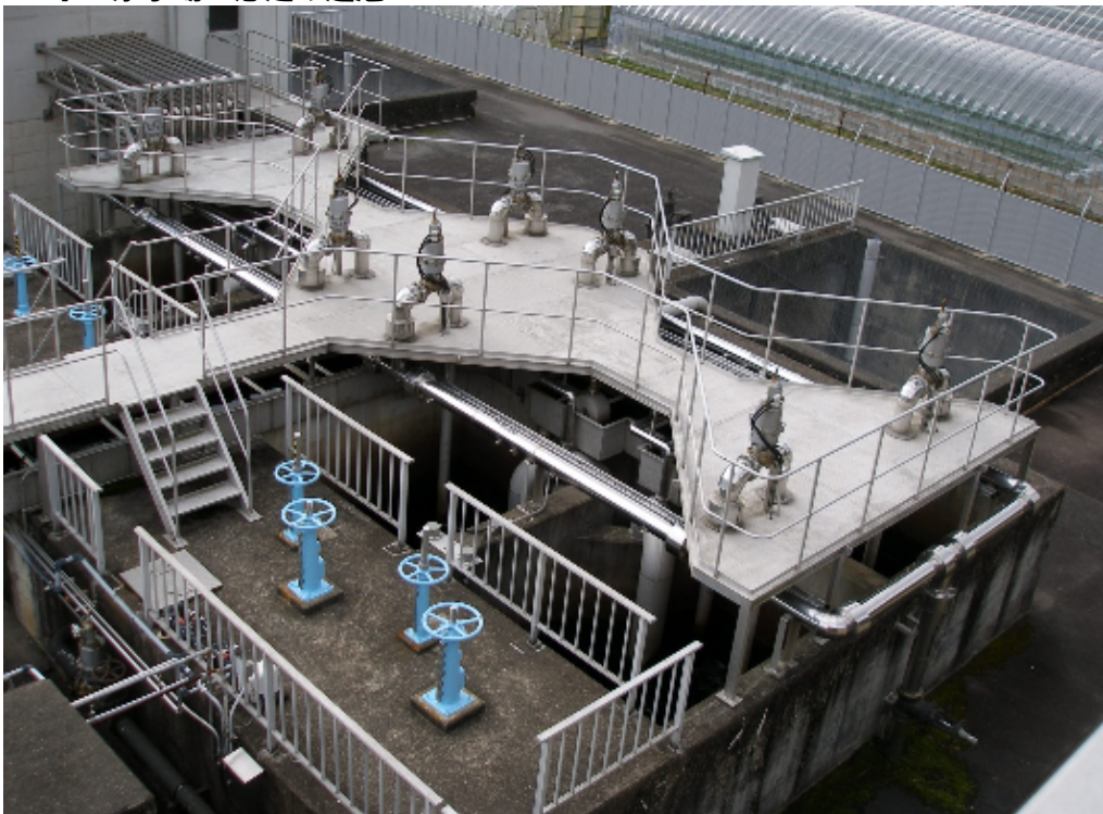
平山浄水場では急速ろ過方式による浄水処理を行っています。
