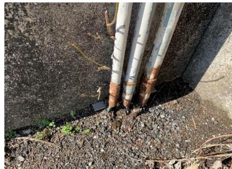
劣化した電線管及び電線の例
