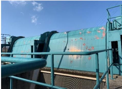
排水機場除塵機の外装劣化の例
