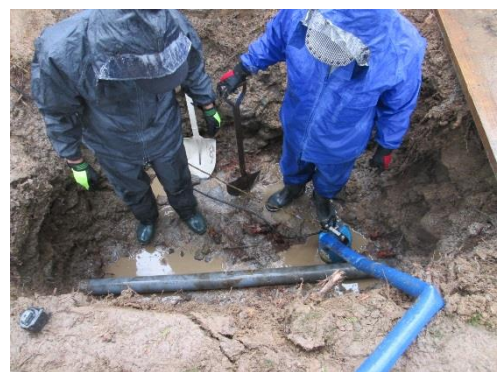
配管の漏水
