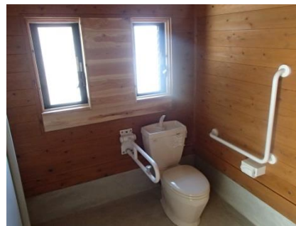
（多目的トイレ）
