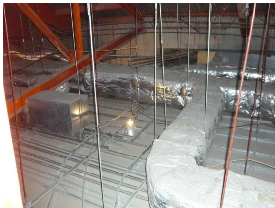
○大ホール 天井裏
