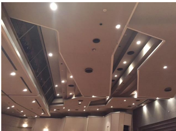
○ 大ホール吊天井
