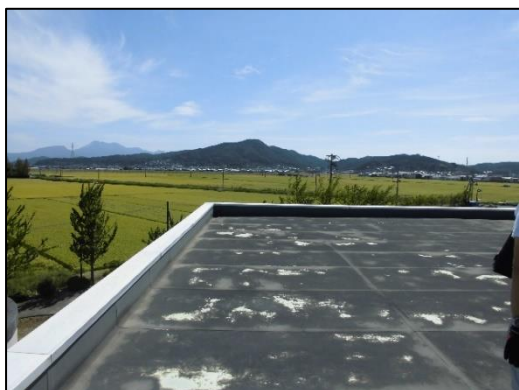
屋上防水シートの状況
