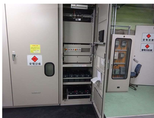
【設備】直流電源装置蓄電池の更新
