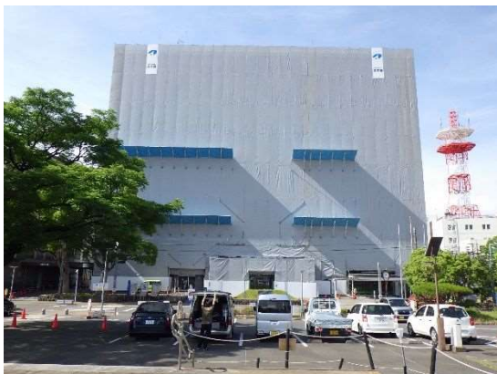
【外壁】外壁補修工事
