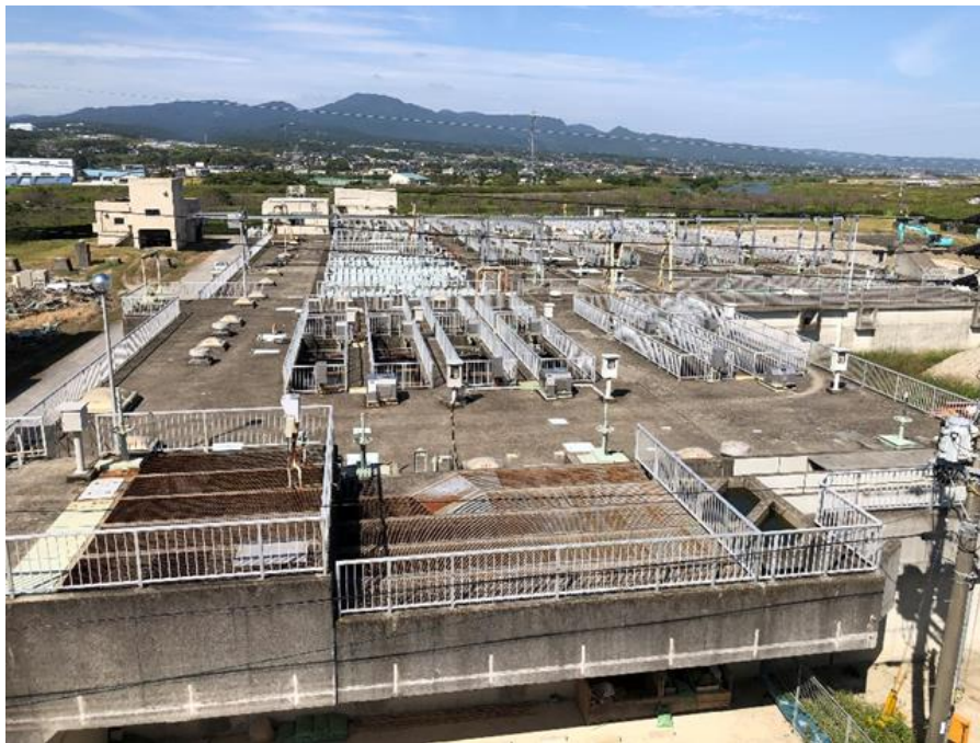
諫早中央浄化センター水処理棟
