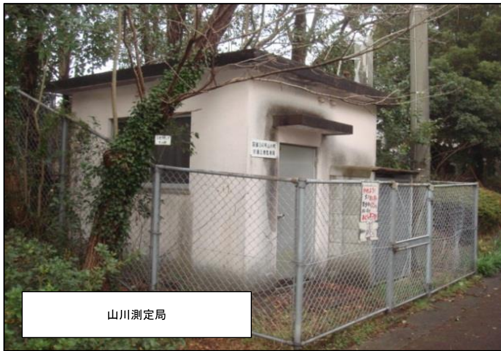
国道34号線測定状況
