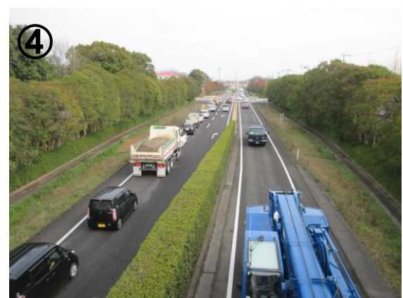
④ 用地・環境施設帯の現状（中尾町交差点付近）
