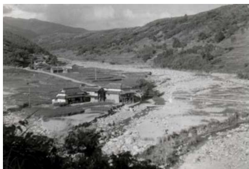
流出した蒲生田橋（湯野尾町・富川町） S32年撮影
