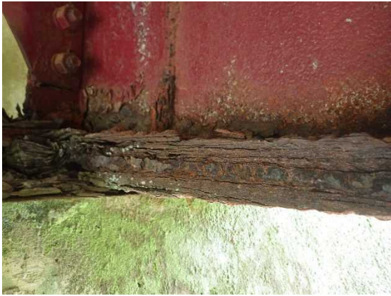
鋼桁の腐食
