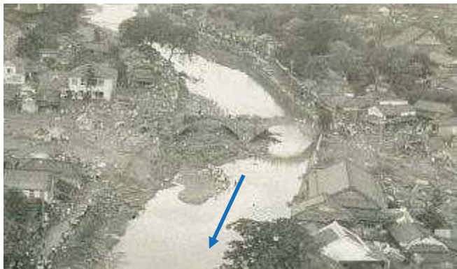
昭和32年7月25日 諫早大水害 本明川の氾濫による市中心部の 被災状況 (中央は眼鏡橋)
