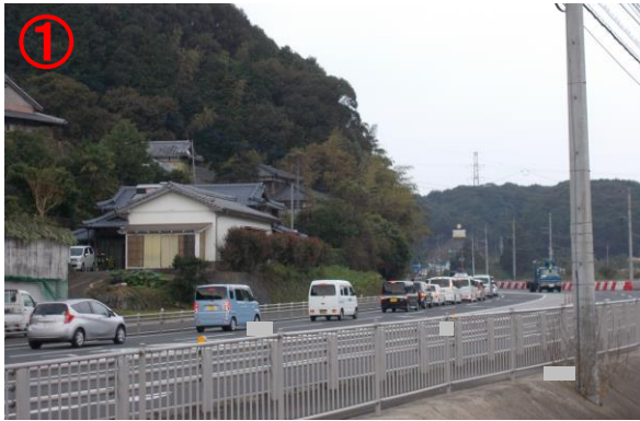
① 混雑状況 (花高入口交差点付近～農道入口交差点付近)
